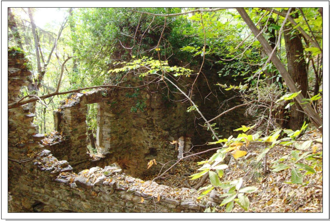
Figura 10: Il degrado degli edifici di Prada
